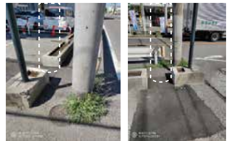
歩道に大きくはみ出した電柱を点線の位置に移設します。
